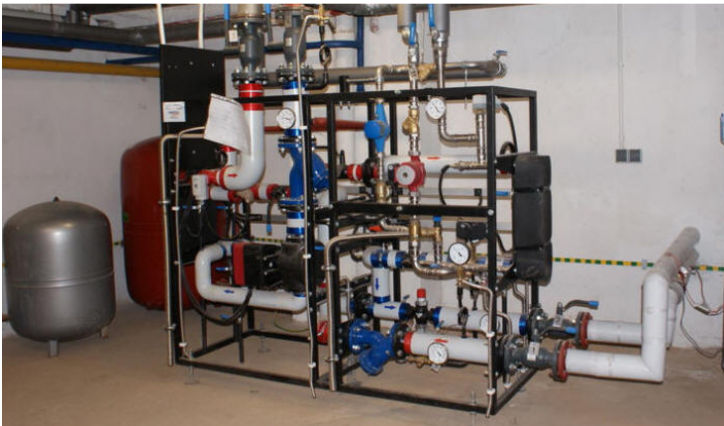
Fot. Kompaktowy węzeł cieplny (fot. Sanpro)
